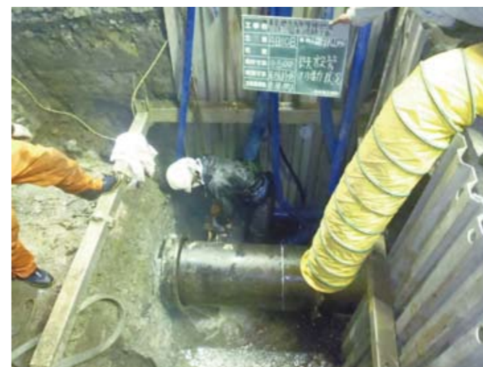
漏水修繕の様子(宮城野区小鶴、口径500mm)
