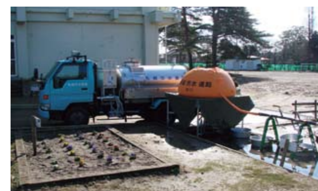
仮設水槽の設置
