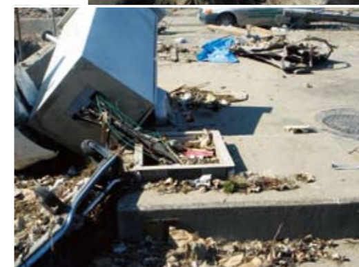
中野沼向流量計の被害
