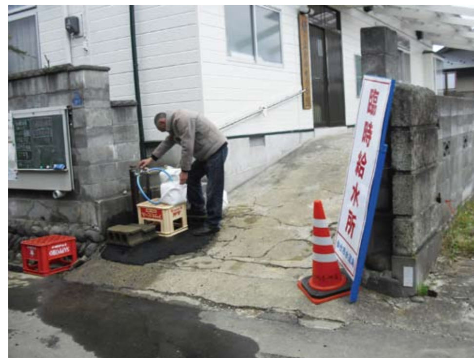
臨時給水栓の設置
