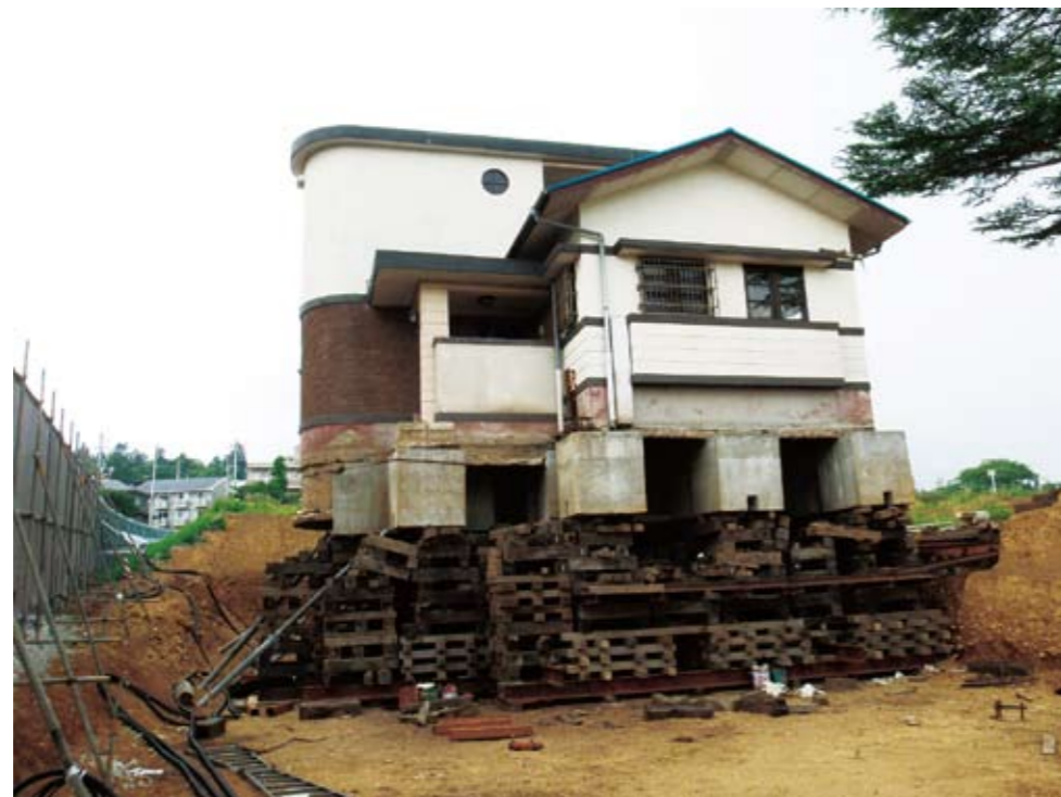
荒巻配水所旧管理事務所（曳家移設工事中に被災し、やむを得ず解体）
