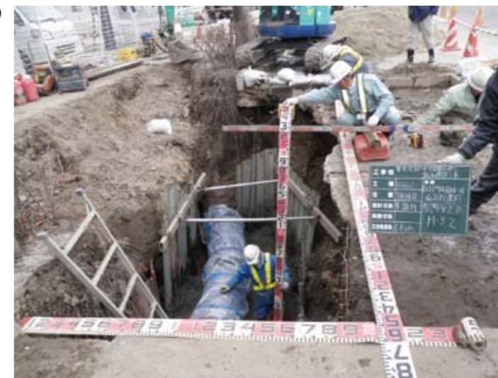
漏水修繕の様子(若林区卸町、口径600mm)
