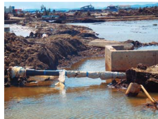
津波に流されなかった耐震管(若林区荒浜、口径150mm)
