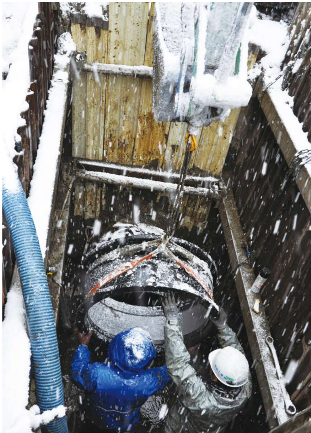
雪の中で続けられる復旧作業(国見第二配水幹線漏水修繕、口径800mm)
