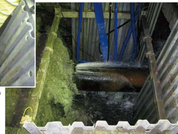
漏水修繕の様子(宮城野区小鶴、口径500mm)
