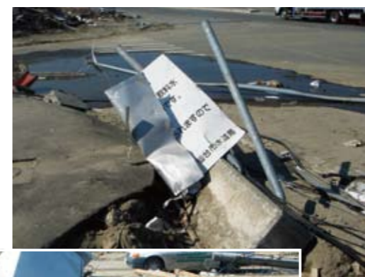
津波に流されなかった耐震管(若林区荒浜、口径150mm)
