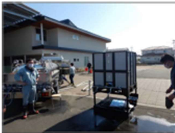
山元町への仮設水槽設置応援派遣
