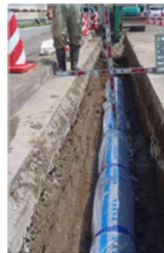
老朽管の更新工事
