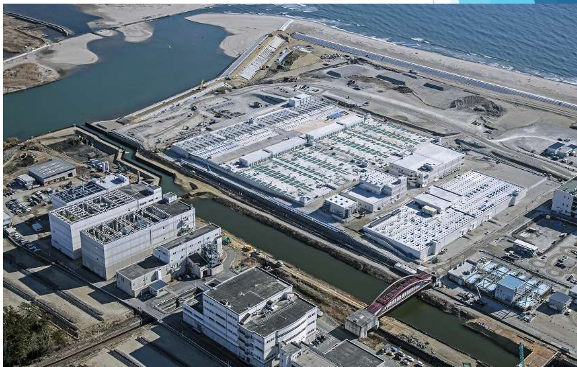
◇南蒲生浄化センター◇
