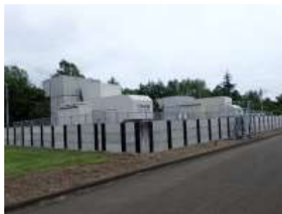
浸水防止壁の設置(仙塩・自家発)
