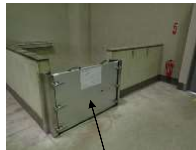
浸水防止施設の設置(仙塩・ポンプ棟シャッター・階段)
