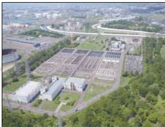
下水処理場 (浄化センター)
