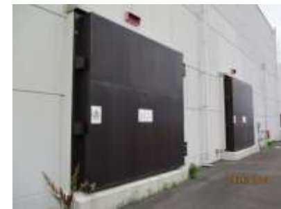
耐水扉の設置(県南)
