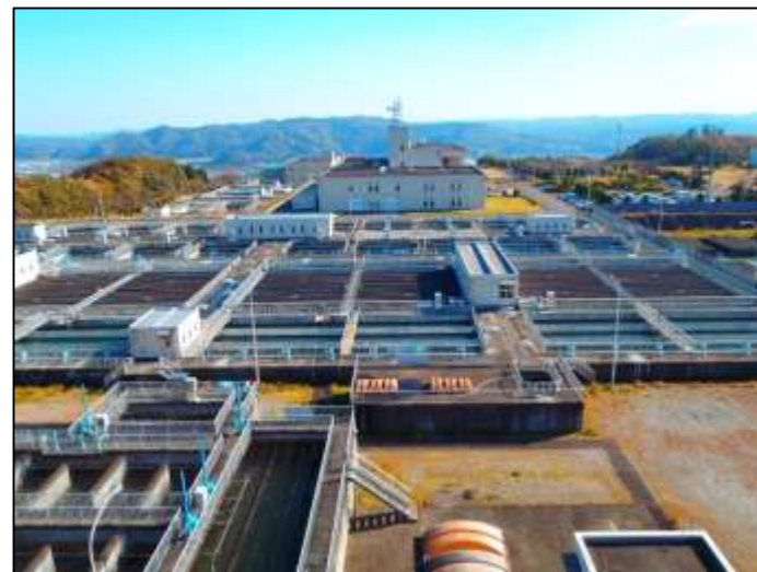
南部山浄水場(白石市内)
