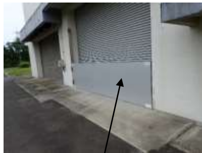
浸水防止施設の設置(仙塩・ポンプ棟シャッター・階段)
