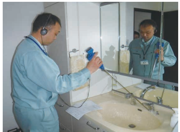
修繕受付センターによる宅内漏水調査
