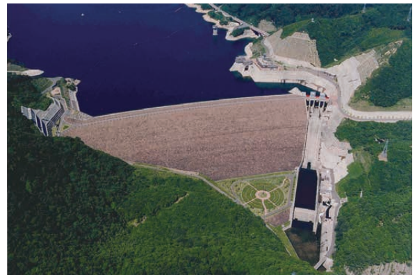
七ヶ宿ダム全景（資料提供：国土交通省東北地方整備局）
