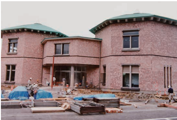
建設中の水道記念館
