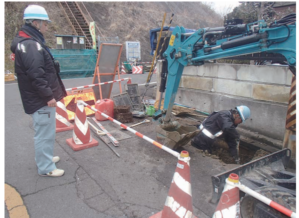
修繕受付センターによる工事立ち合い
