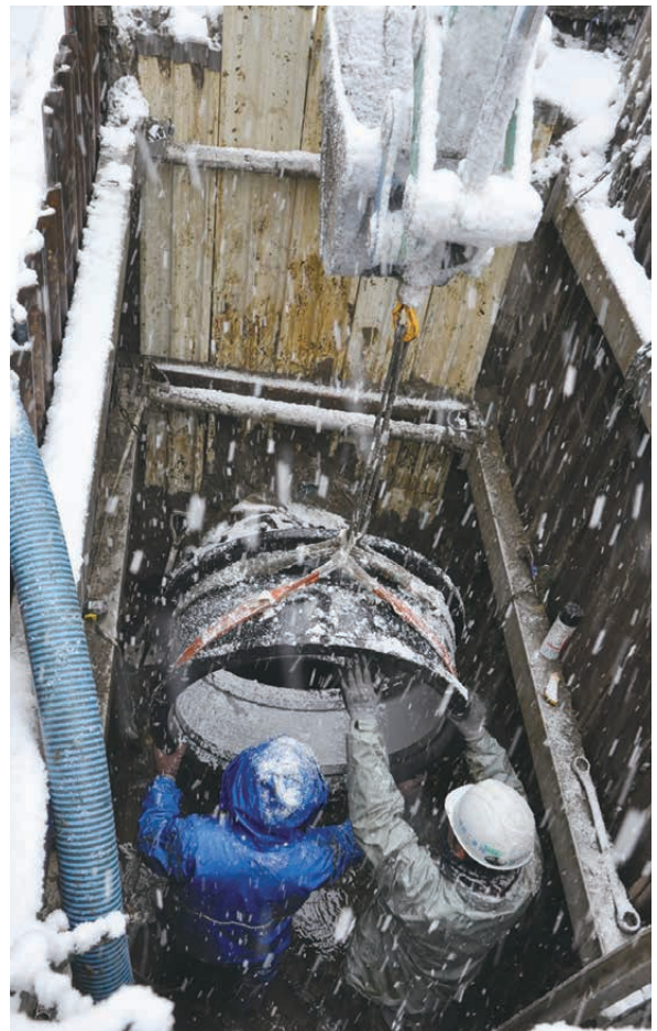
東日本大震災での復旧作業
