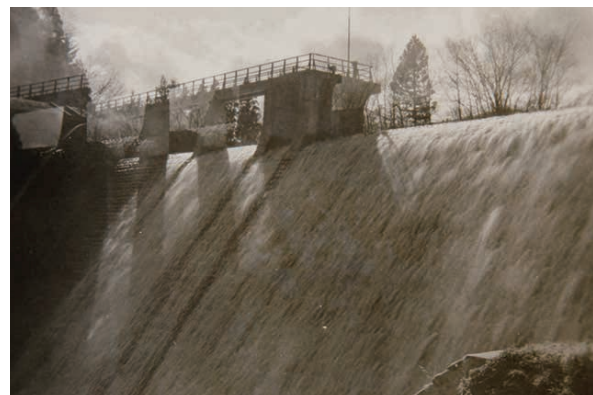
青下第三ダム
