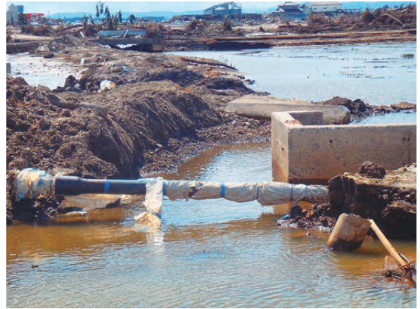
東日本大震災の津波でもき出しになった耐震管（若林区荒浜）
