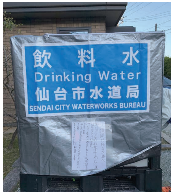
仮設水槽（令和元年 東日本台風での丸森町への給水応援）
