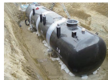
非常用飲料水貯水槽
