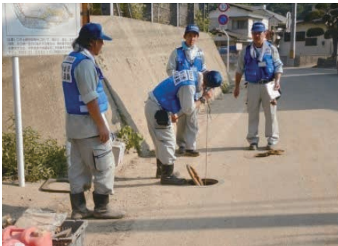
平成30年7月豪雨（西日本豪雨）での漏水調査支援（愛媛県宇和島市）
