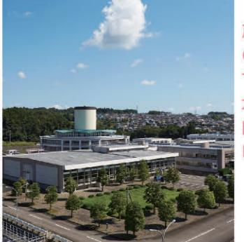
昭和53年に完成した、施設能力190,500m<sup>3</sup>/日の仙台市最大の浄水場です。釜房ダム貯留水を水源として、主に宮城野区・若林区・太白区へ給水しています。
