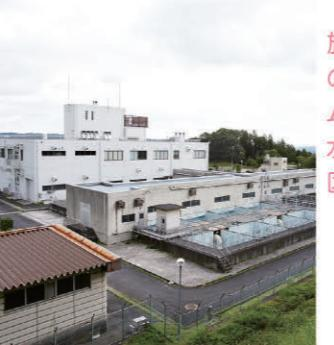
昭和58年に完成した、施設能力60,600m<sup>3</sup>/日の浄水場です。七北田ダム放流水と宮床ダム貯留水を水源として、主に泉区へ給水しています。
