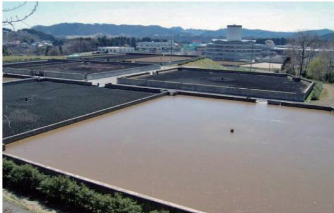
茂庭浄水場天日乾燥床 太陽のエネルギーで乾燥させる「天日乾燥方式」を採用し、エネルギー消費を抑えています。
