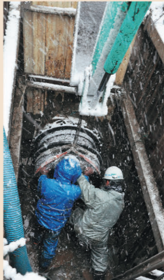
懸命な復旧作業(青葉区旭ヶ丘)
