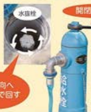
ホースがしっかり接続されているのを確認する
