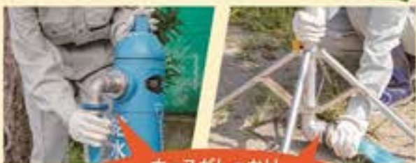
ホースがしっかり接続されているのを確認する
