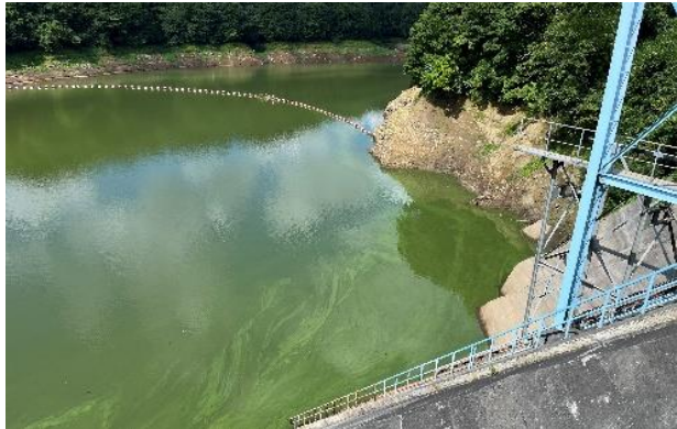
アオコが発生した七北田ダムの様子
