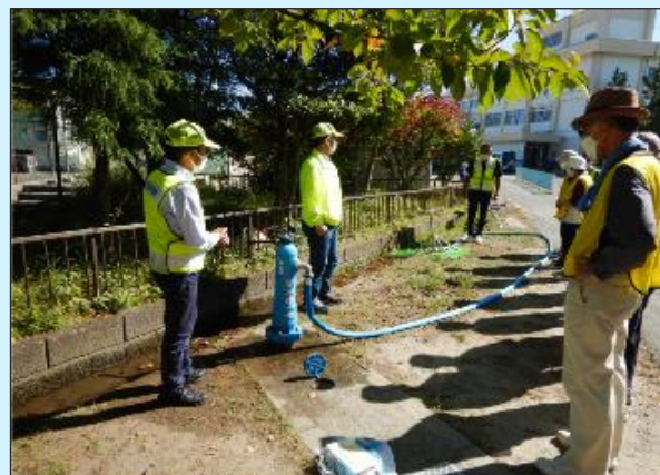
地域における災害時給水栓の開設訓練
