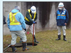
仕切弁の操作手順を確認する訓練の様子
