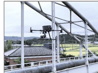
ドローンによる水管橋点検調査
