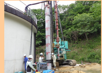
配水所における耐震化工事
