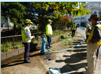
地域における災害時給水栓の開設訓練
