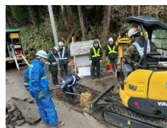
宮城県管工業協同組合と連携した復旧作業
