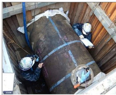
管体調査（管路情報の収集・蓄積）
