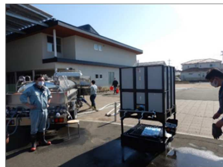
山元町への仮設水槽設置応援派遣
