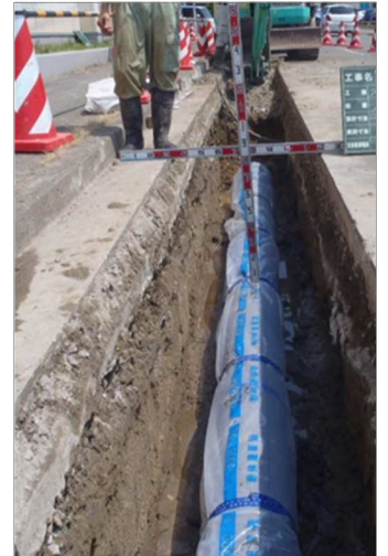
老朽管の更新工事
