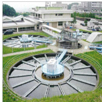
国見浄水場 (稼働開始から59年経過※)
