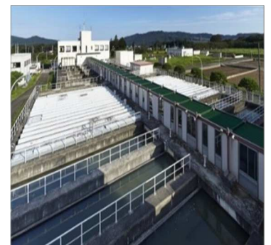
中原浄水場 (全面改修から43年経過※) ※令和2年度末現在
