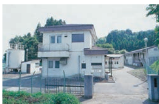
熊ヶ根浄水場
