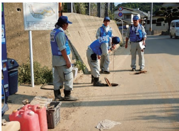
平成30年の西日本豪雨での漏水調査支援
