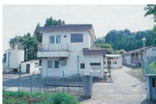
熊ヶ根浄水場
