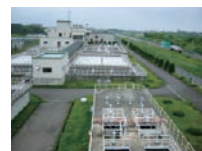
廃止した富田浄水場
