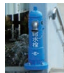
災害時給水栓
