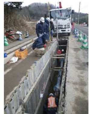
管路の更新工事
