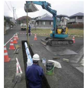
管路の更新工事
