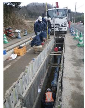
管路の更新工事
