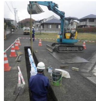
管路の更新工事
