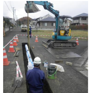
管路の更新工事
