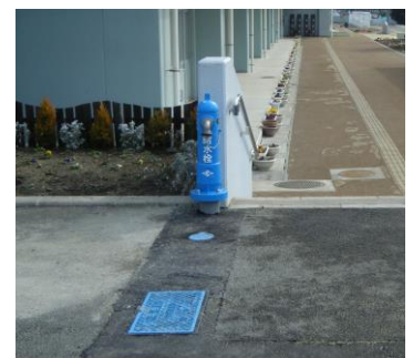
災害時給水栓
