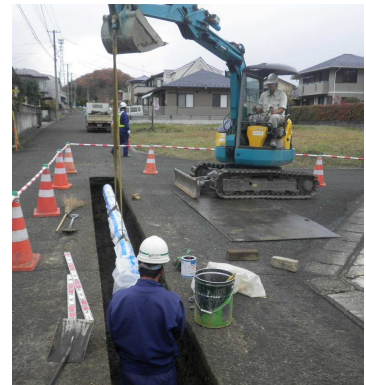
管路の更新工事
