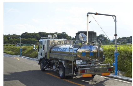
給水車用注水補給設備
