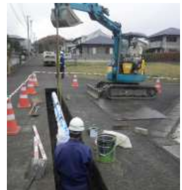
管路の更新工事
