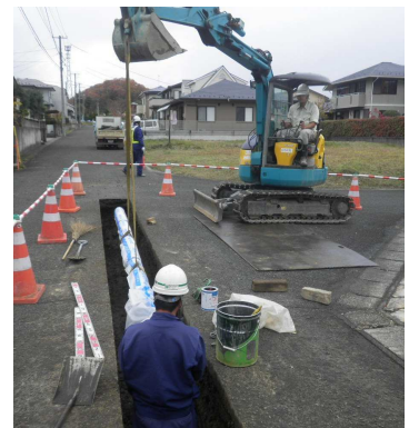
管路の更新工事
