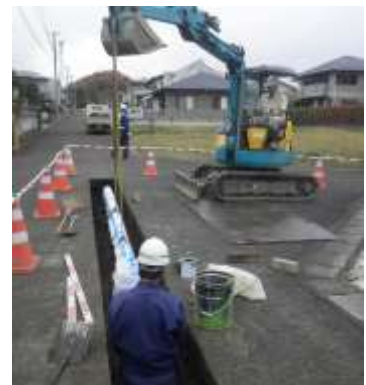
管路の更新工事
