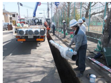
耐震管への更新工事
