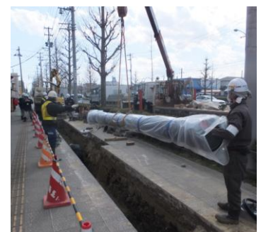
耐震管への更新工事
