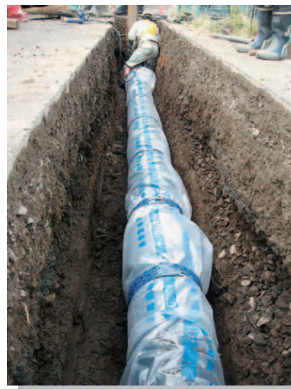
ダクタイトル鉄管（NS型継手）の布設
