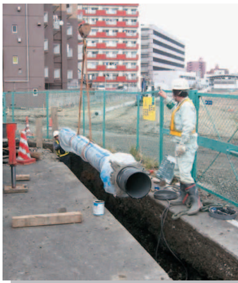
ダクタイトル鉄管（NS型継手）の布設
