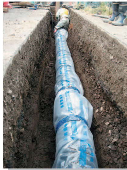
ダクタイル鋳鉄管（NS型継手）の布設
