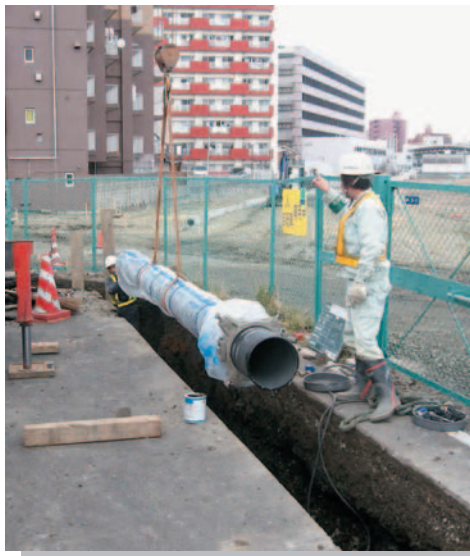
ダクタイル鋳鉄管（NS型継手）の布設
